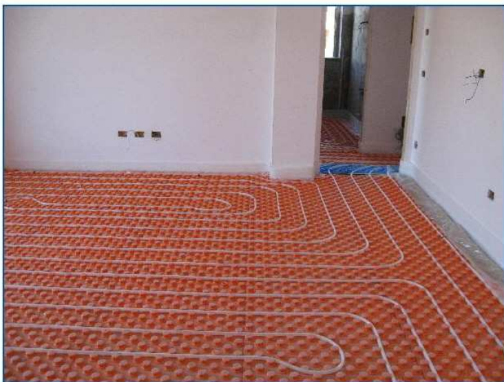
Posa pannelli radianti
